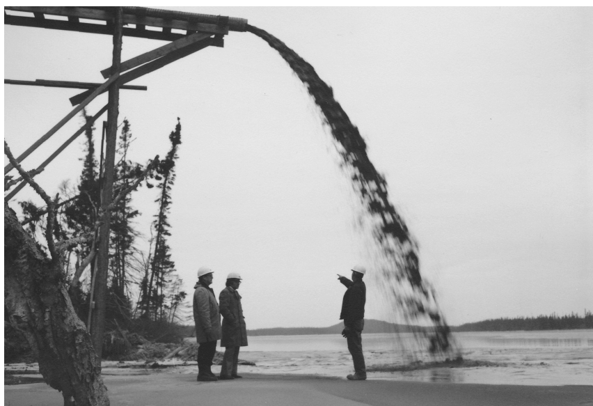
Figure 18 - Pipeline à résidus miniers de la mine Principale, qui jette les résidus dans le lac aux Dorés (P74, S2, D1, P39)
