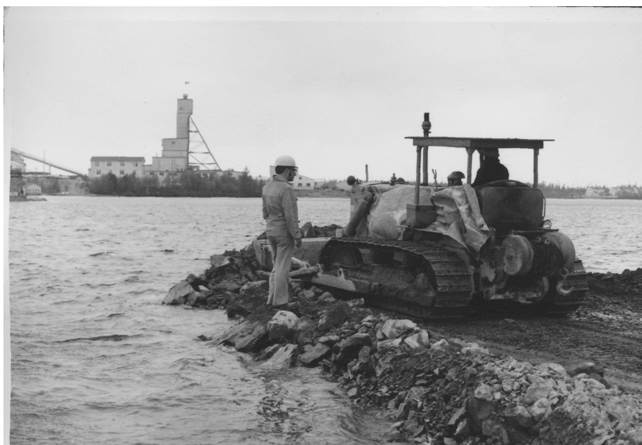
Figure 17 - Construction d'un « causeway » sur le lac aux Dorés (P74, S2, D1, P49)
